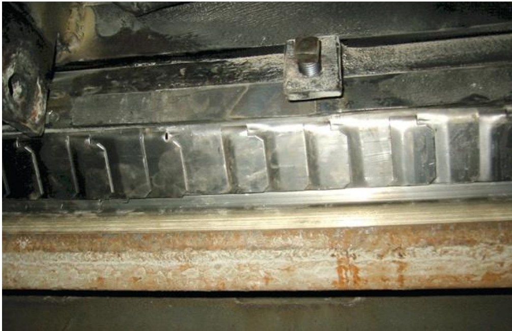
شکل ۷. سیستمهای آب بندی محیطی
