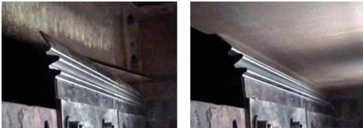
شکل ۵. نمونه ای از سیستمهای آب بندی ژونگستروم
