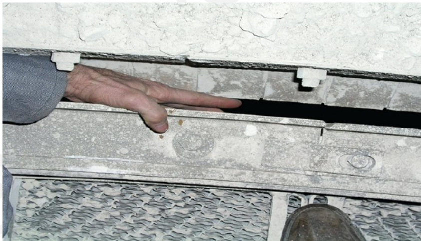
شکل ۸. سیستمهای آب بندی قدیمی
