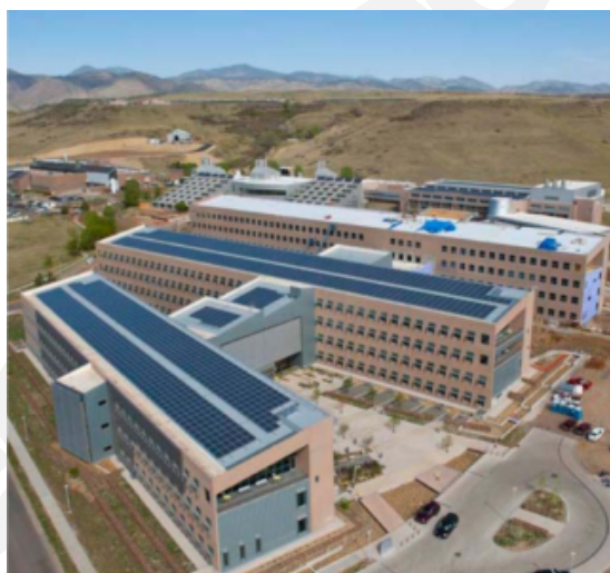
شکل ۱-۲۶. ۴۵۰ کیلووات سلول خورشیدی نصب شده روی بام ساختمان
