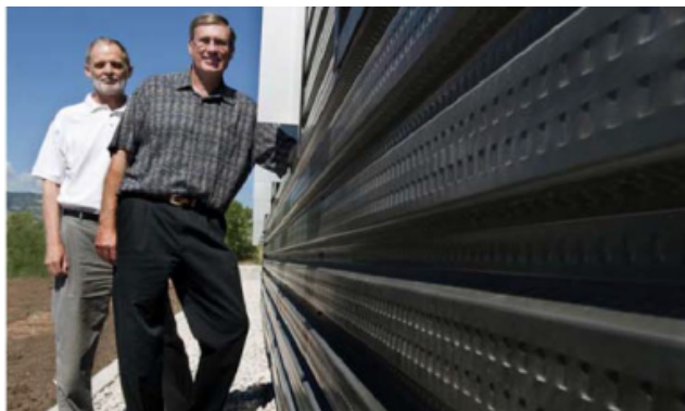
شکل ۱-۲۴. کلکتور خورشیدی نفوذپذیر ضلع جنوبی
