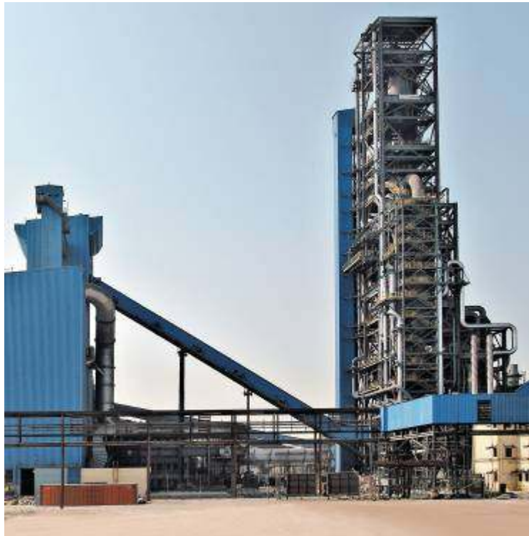
شکل ۵-۱۰. انتقال گرم آهن اسفنجی توسط نقاله در فولاد حدید عربستان
